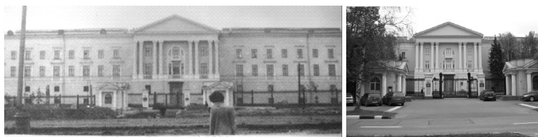
Рис. 6. Новое здание ИМЕТ на Ленинском проспекте, 49 в различные времена. Годы: 1953 (слева), 2011 (справа) (Архив лаборатории).
